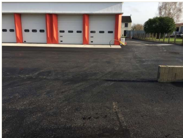
Réhabilitation des façades et de la cour du centre de secours de BAR SUR AUBE
