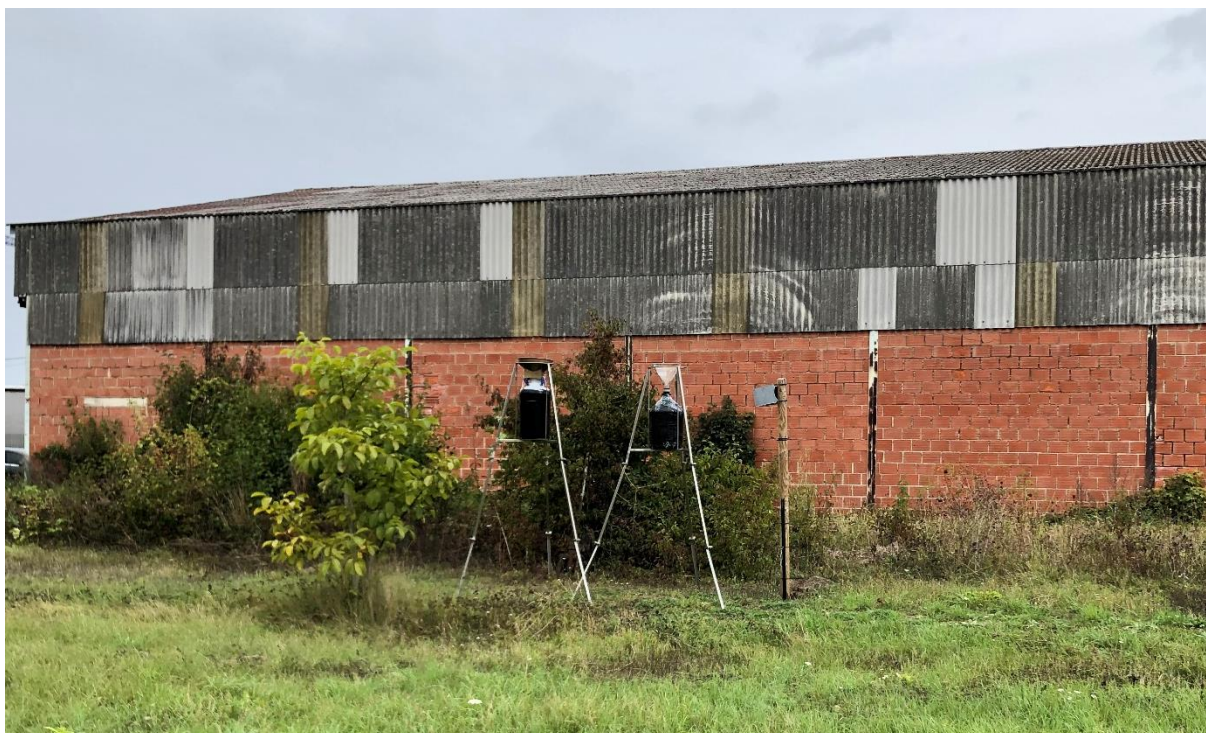
Figure 12. Photo du dispositif de mesures installé à proximité des jauges Owen sur la station 1, rue de la Gare, au sud-ouest du site
